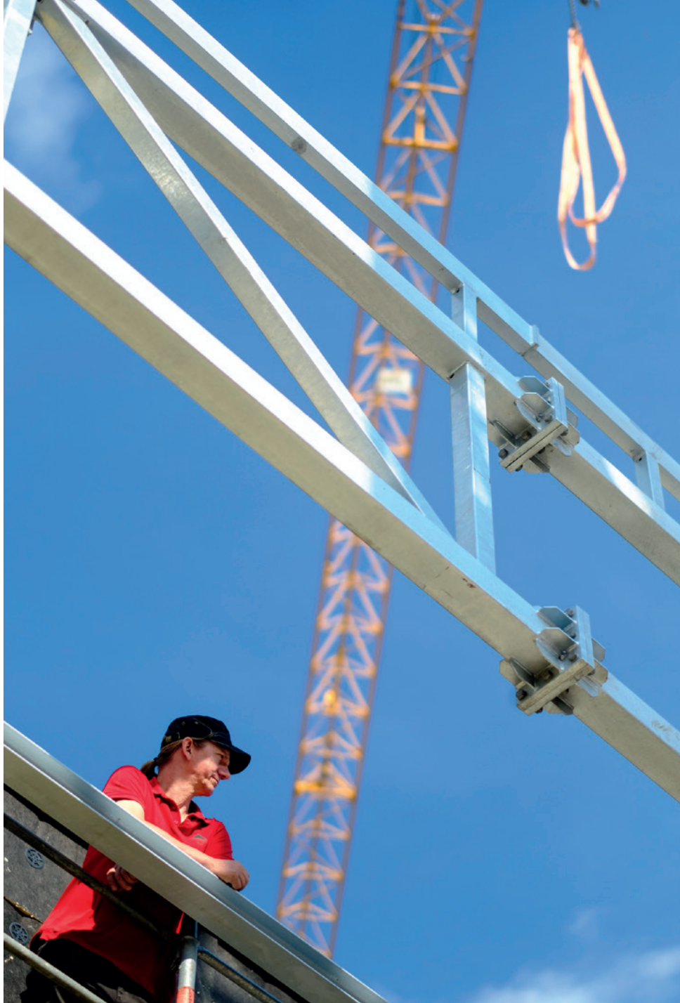
Feierabend in Sicht. Rudi Bösler und die massive Konstruktion des vorkragenden Dachs. Später wird sie die Fassadenplatten tragen.
